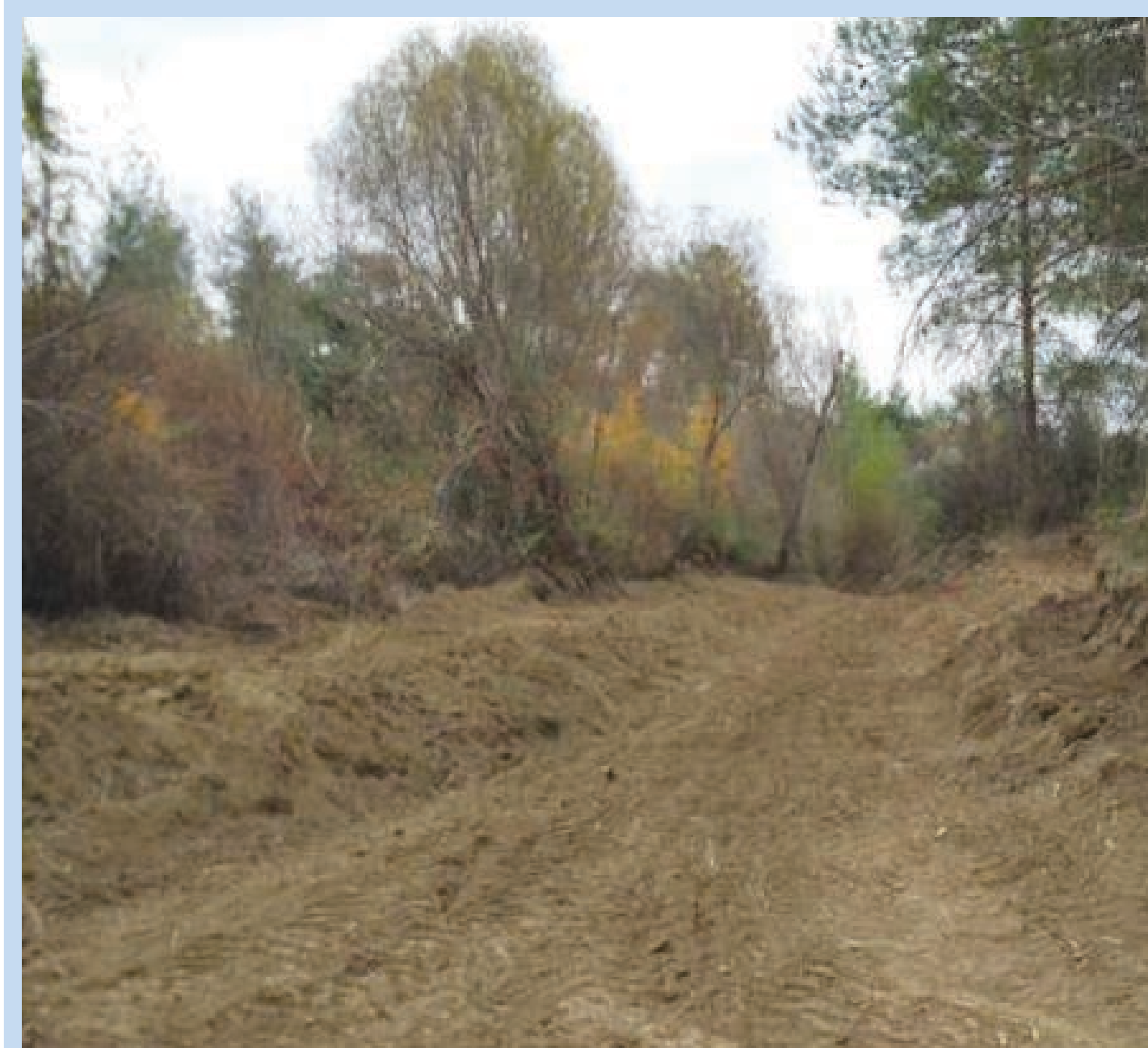
Διαμόρφωση αναβαθμίδων εκατέρωθεν της κοίτης για τη δημιουργία χώρων φύτευσης
