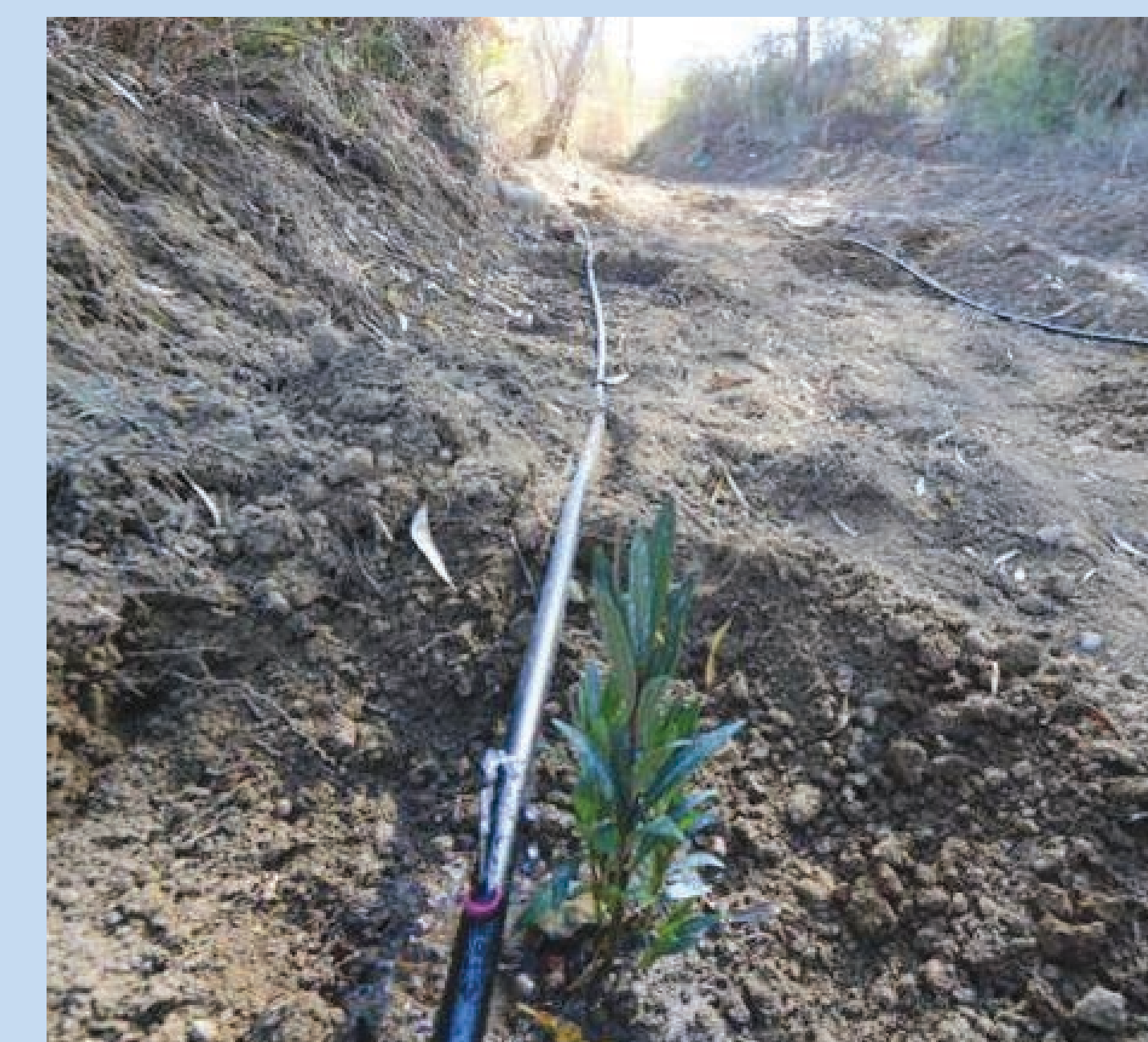
Φυτεύσεις δενδρυλλίων και τοποθέτηση συστήματος άρδευσης
