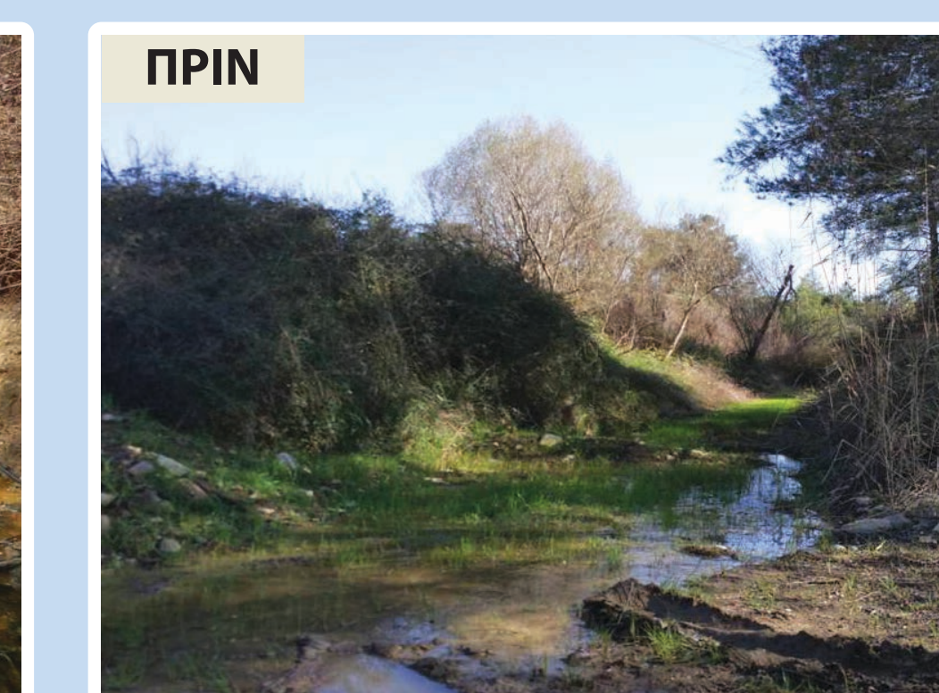
ΠΕΡΙΟΧΗ 3 πριν και μετά την εκτέλεση των έργων αφαίρεσης ξενικών ειδών, φύτευσης και τοποθέτησης του αρδευτικού συστήματος
