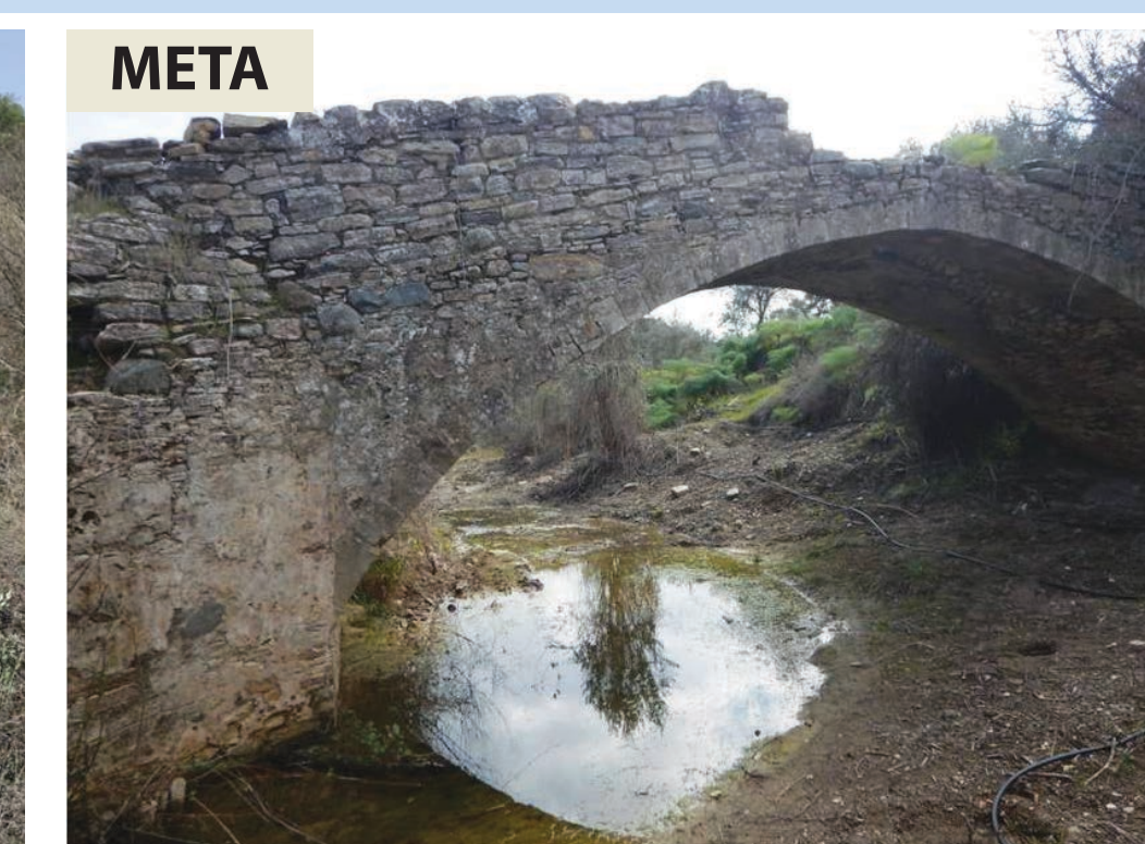
ΠΕΡΙΟΧΗ 1 πριν και μετά την εκτέλεση των έργων αφαίρεσης ξενικών ειδών, φύτευσης και τοποθέτησης του αρδευτικού συστήματος
