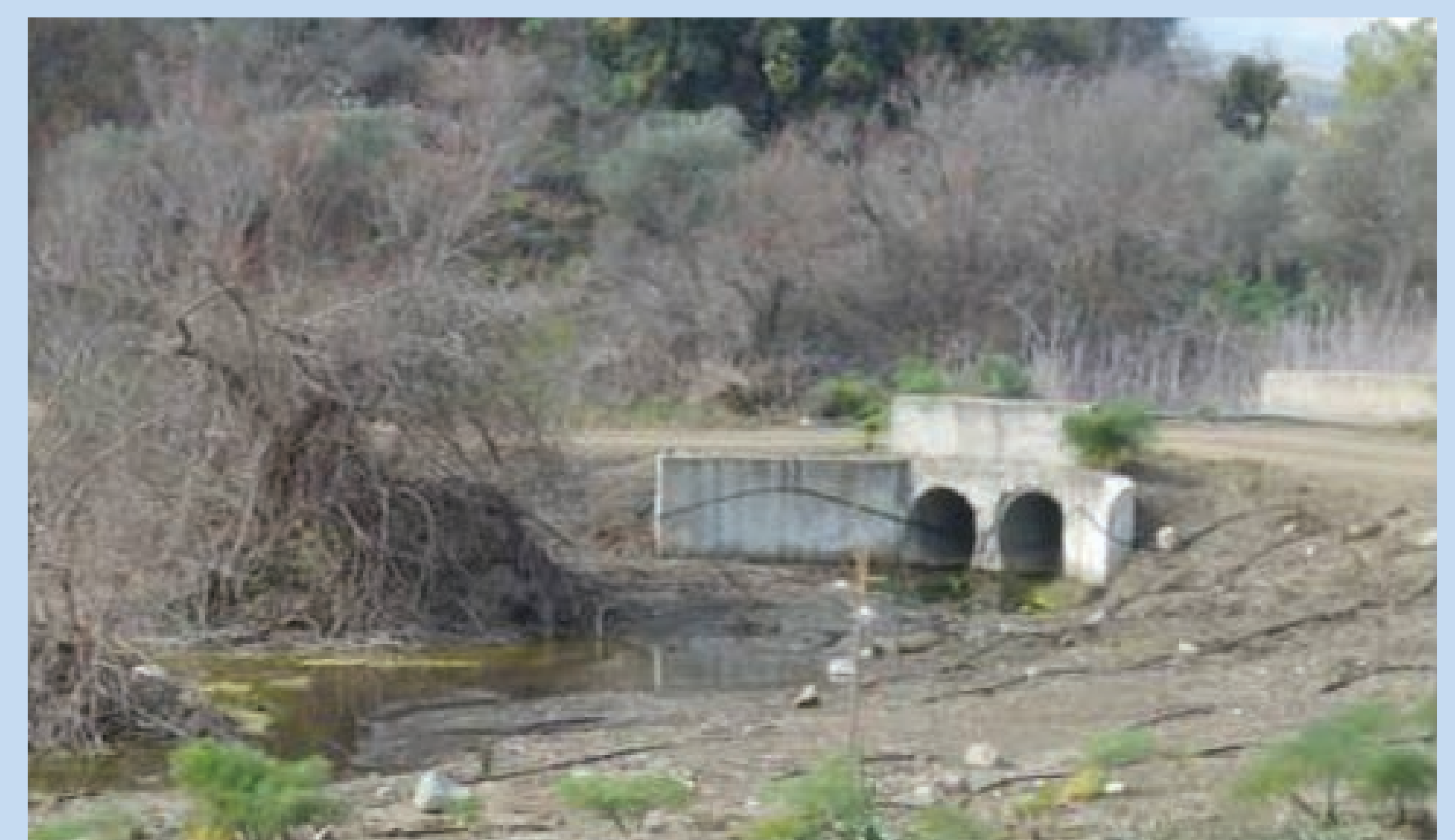
Απελευθέρωση της κοίτης από την πυκνή θαμνώδη βλάστηση και διαμόρφωση των πρανών του ποταμού με τη δημιουργία πολυλοκότητας στη διατομή της κοίτης
